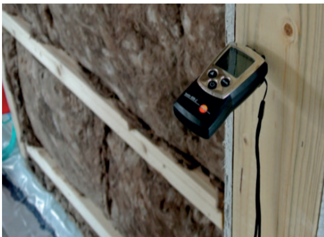
Rychlé měření vlhkosti dřevěných konstrukcí přímo na stavbě.
