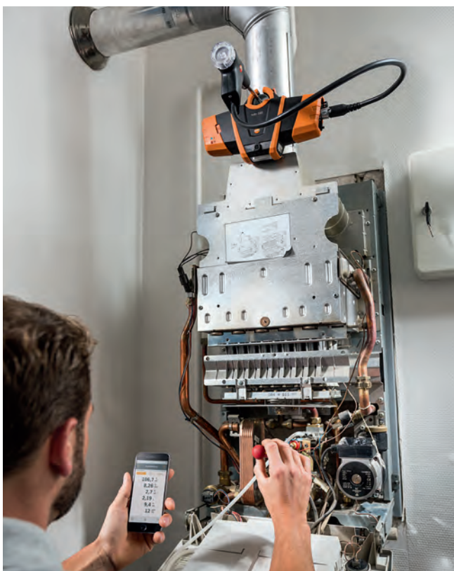
Pro seřizovací práce je nezbytný analyzátor spalin např. testo 330i
