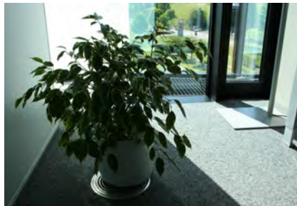
Obr. 2: Zakrytá vzduchová výustka.
